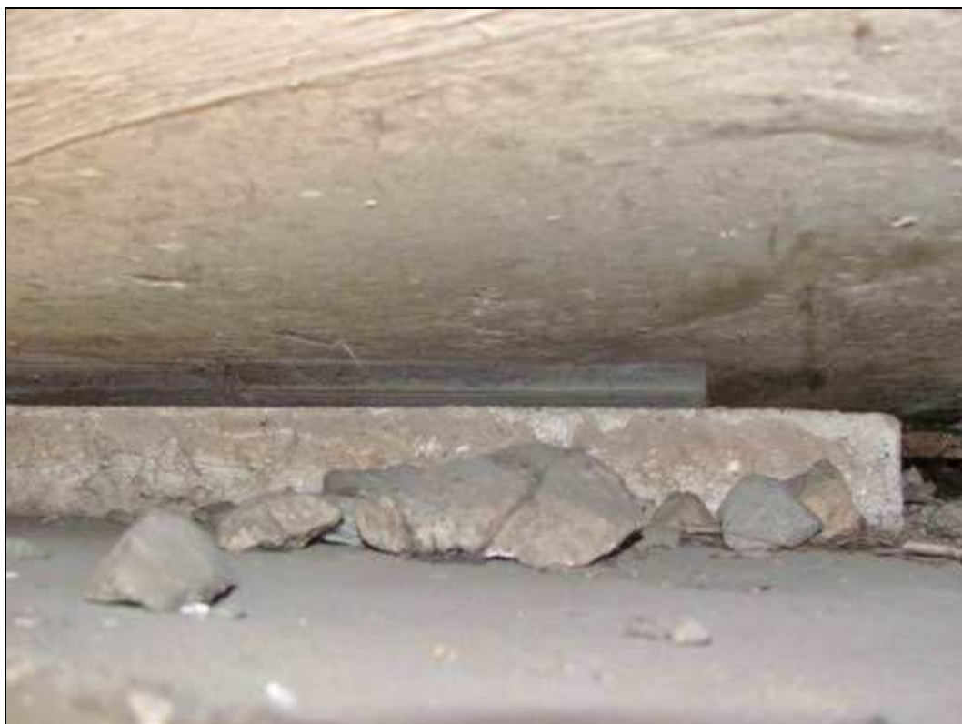
Foto 4: Opěra OP1, pohled na elastomerové ložisko.
