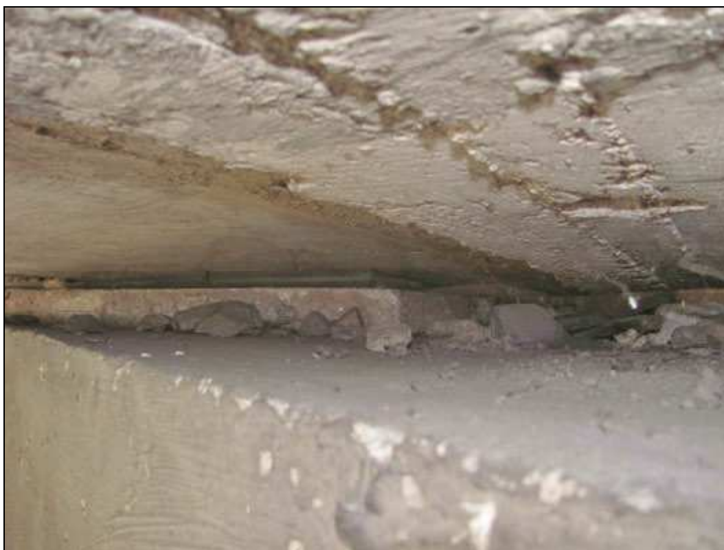
Foto 10: Opěra OP1, pohled na elastomerové ložisko.
