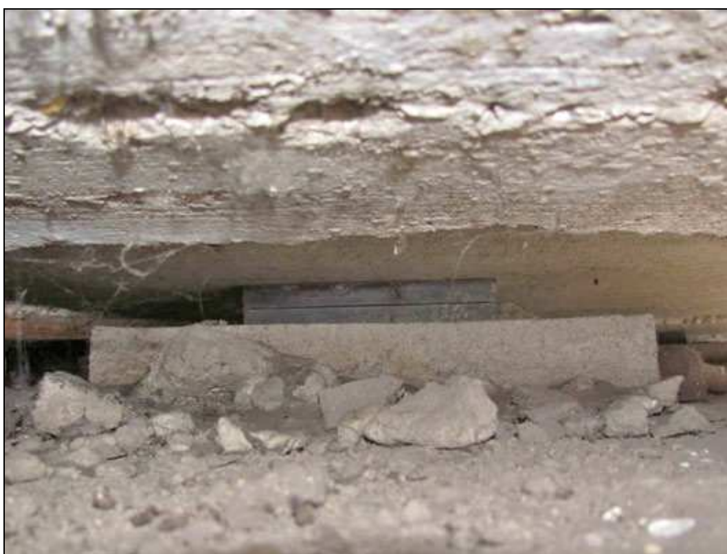
Foto 6: Opěra OP2, pohled na elastomerové ložisko.
