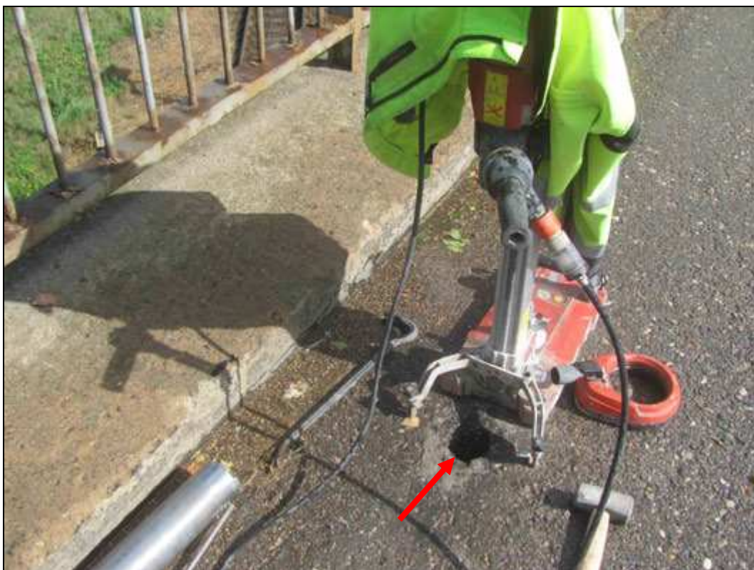
Foto 1: Pohled do provádění jádrového vrtu V9, pro stanovení skladby vozovky.
