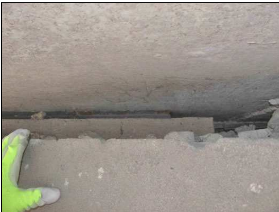
Foto 8: Opěra OP2, pohled na elastomerové ložisko.
