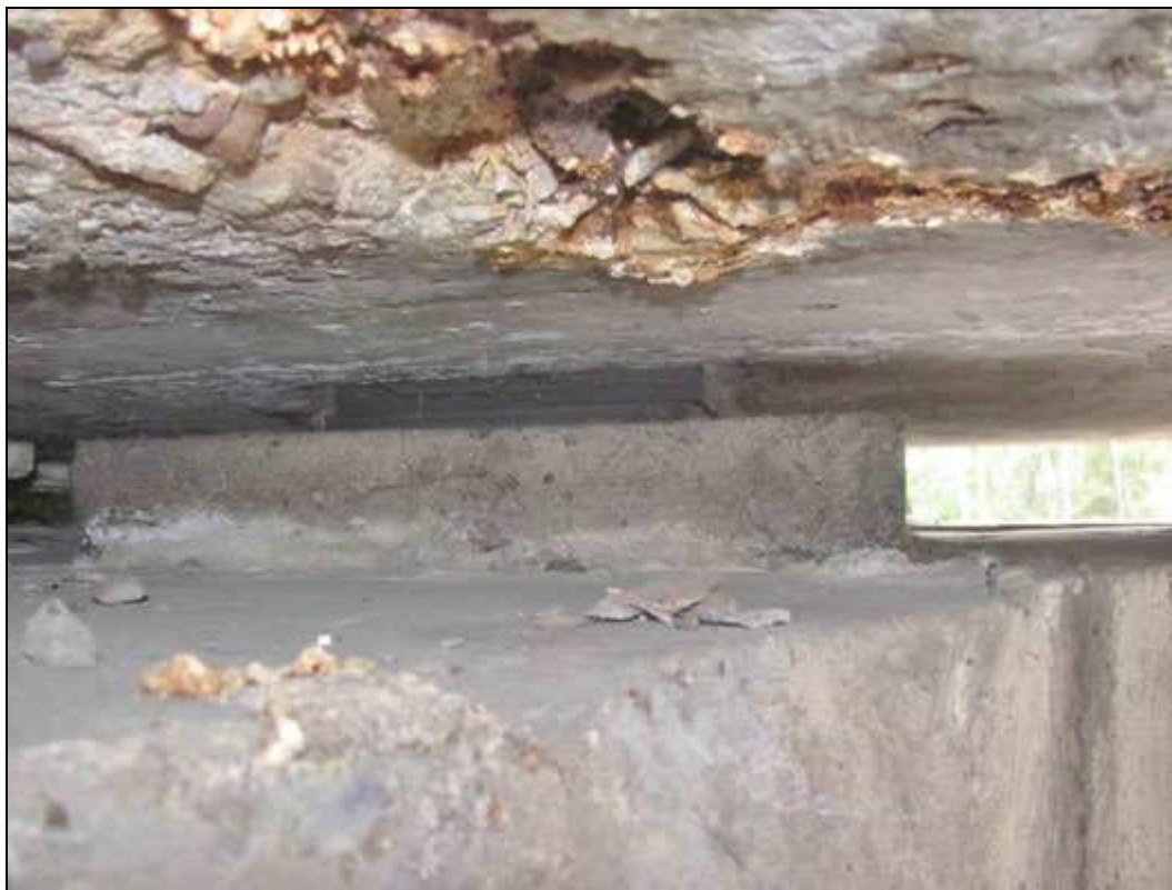
Foto 9: Opěra OP1, pohled na elastomerové ložisko.
