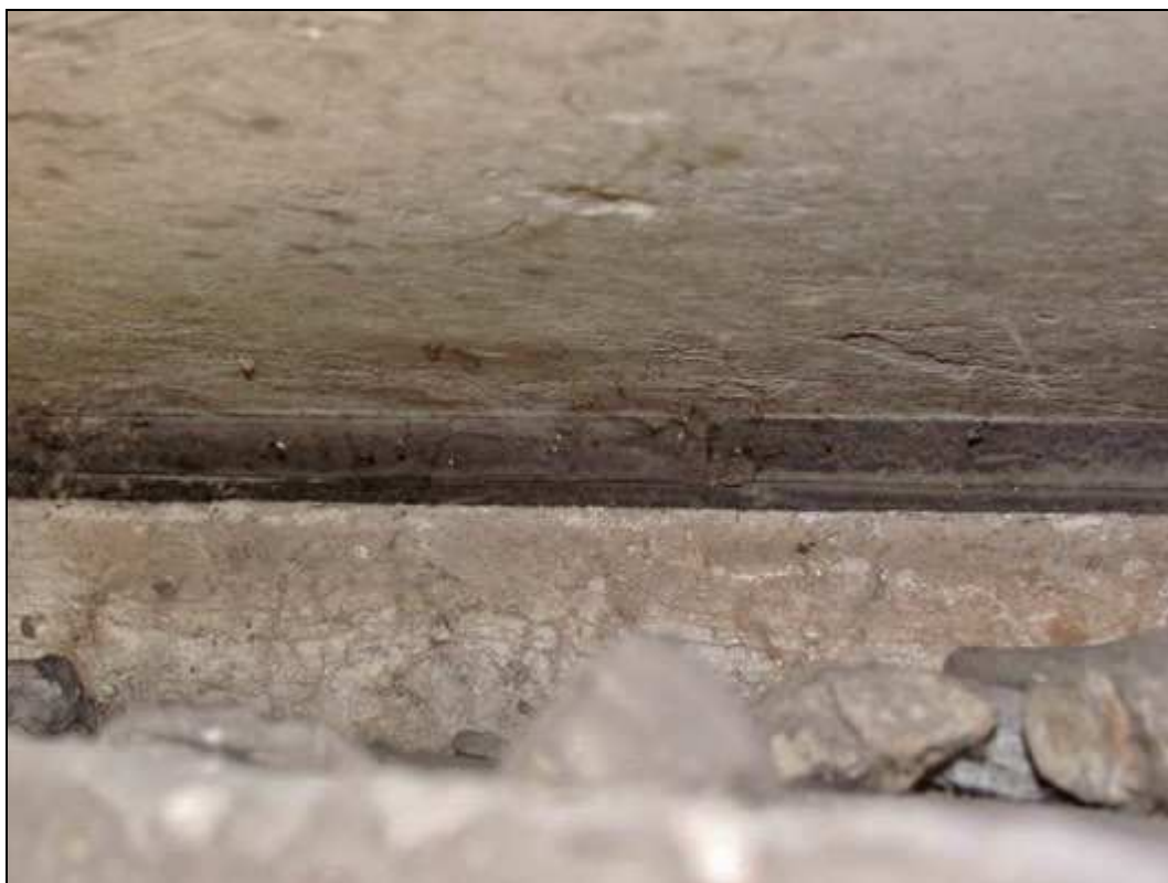
Foto 5: Opěra OP1, pohled na elastomerové ložisko.
